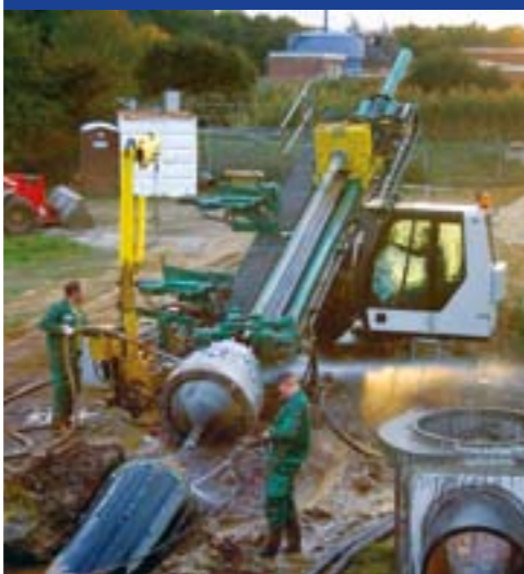
100 to-Anlage nach erfolgreichem Rohreinzug
