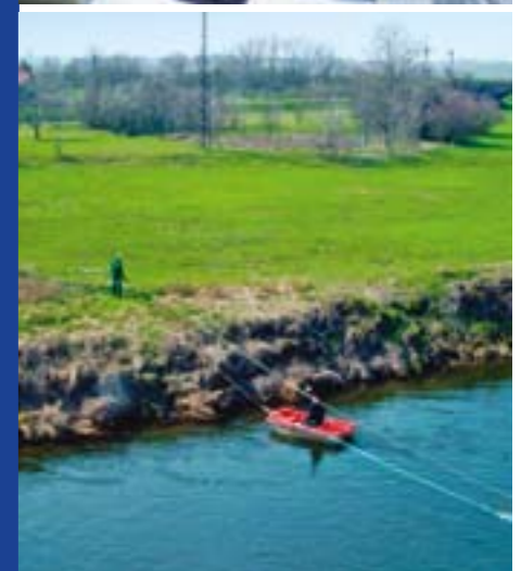
von oben: Vermessung der Bohrstrecke vor Ort Planung und technische Vorbereitung Ermittlung der optimalen Streckenführung
